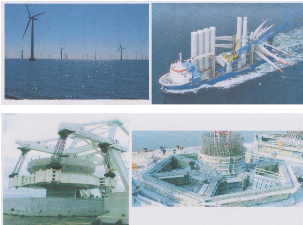
Figure 7 : L'implantation d'éoliennes en mer est une activité industrielle très lourde. En haut : à gauche, vue d'une centrale éolienne, à droite, barge de pose où on distingue les embases, les mâts et les rotors. En bas, création des fondations. Documents WPD.
