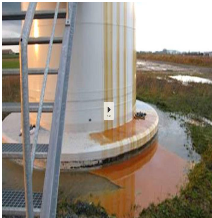
Figure 15 : Fuite d'huile depuis une nacelle sur une éolienne terrestre en 2012 à Leuze-Europe en Belgique.
