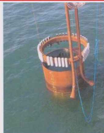
Le « J-Tube » par lequel remonte le câble jusqu'à la plateforme
